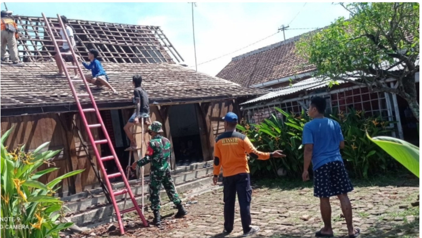
(Foto Istimewa) Gotong Royong pemasangan Genteng Rumah Warga
