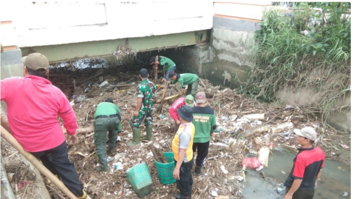
(Foto istimewa) Gotong Royong Pembersihan Aliran Sungai
